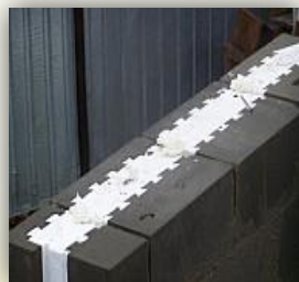
Тепловлаки (толщина стены из кирпича, утеплителя, сетки и штукатурки составляет по ГОСТ 0,67 м)
